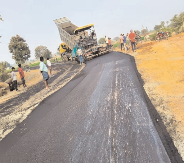
ఈ రోడ్డు నిర్మాణం పట్ల భట్టి విక్రమార్కు కి ప్రత్యేక కృతజ్ఞతలు తెలిపిన గ్రామ ప్రజలు
